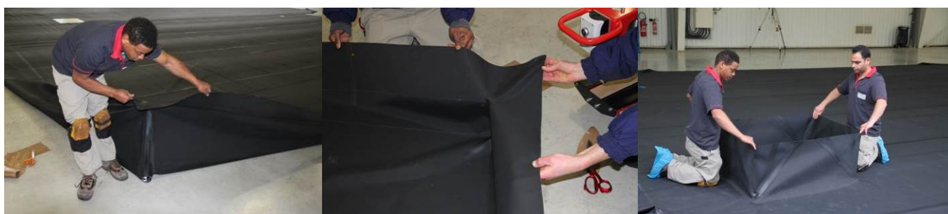
Figure 5 – Exemple de relevés préfabriqués en usine
