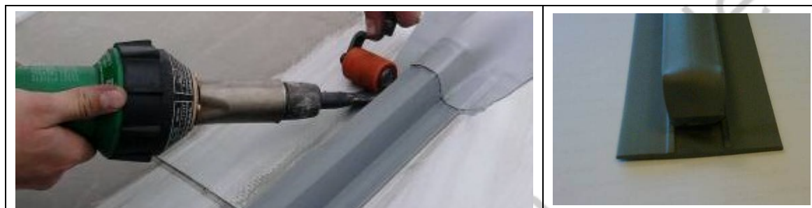
Figure 23 – Photos du mode de fermeture des profilés PVC dans le cas d'une pente nulle
