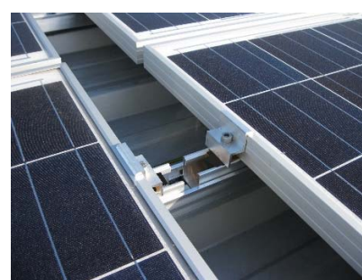
Au joint de dilatation
