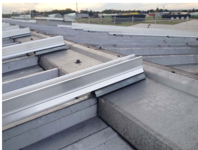
Figure 23 - Illustration de l'utilisation de la rehausse de faîtage (L'entretoise n'est pas représentée sur ces sections)
