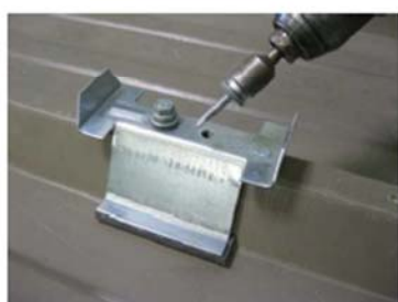
Figure 21 - Illustration de la fixation du perçage des panneaux sandwich et de la pose de l'entretoise (Cas simple vis ; pour le cas double vis voir Figure 25)
