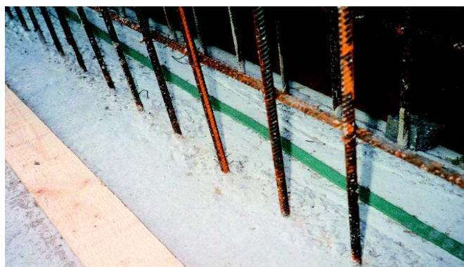
Reprise de bétonnage et joint de construction
