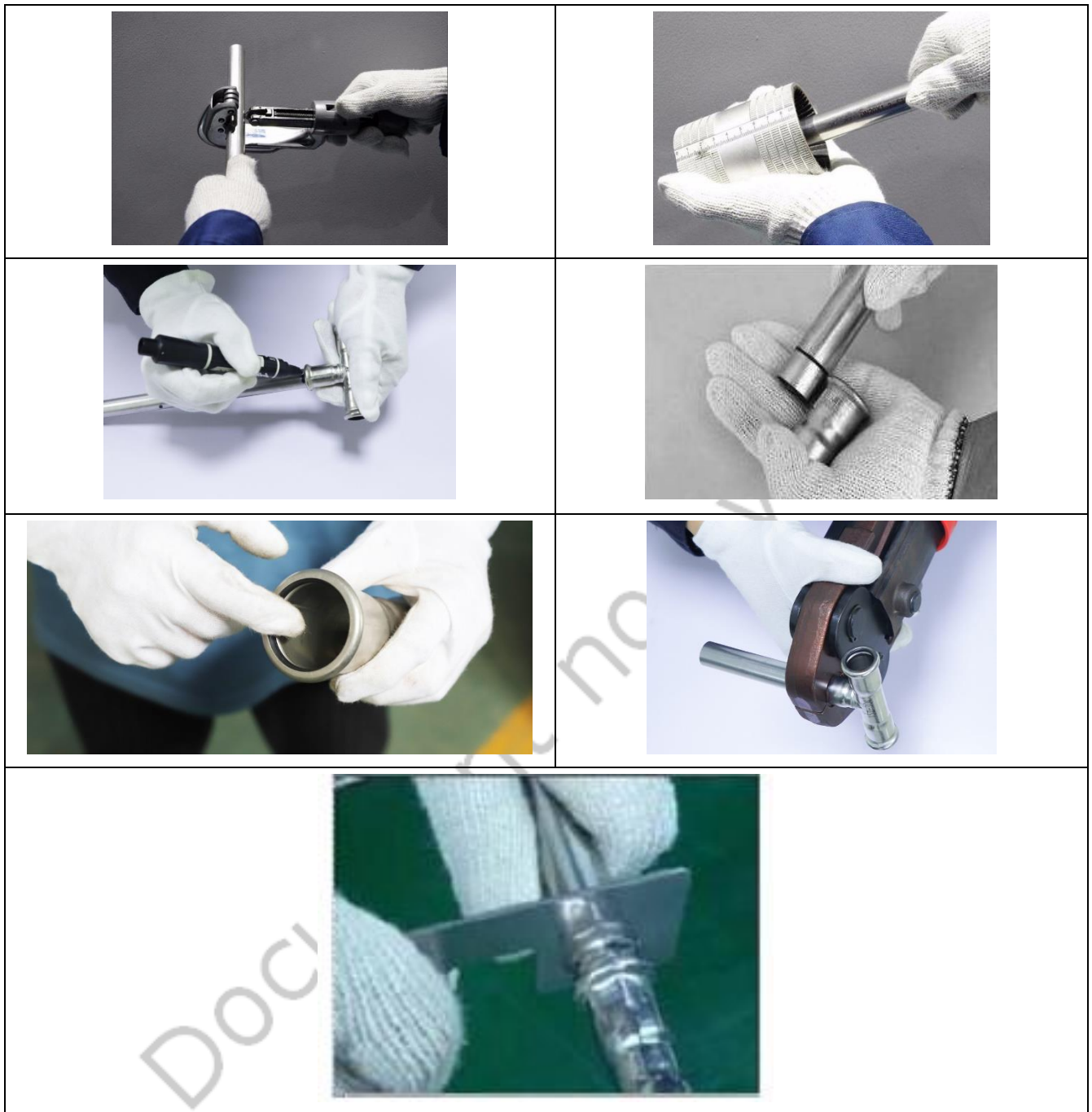
Figure 2 - Réalisation de l'assemblage
