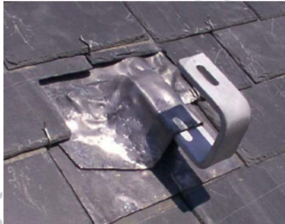
Figure 11d – Support aluminium : installation sur toitures en ardoises avec alaise en plomb
