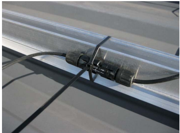
Exemple de cheminement des câbles
