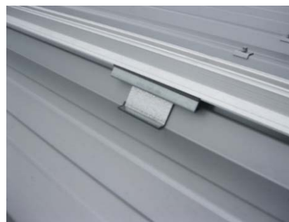
Figure 25 - Fixation du rail sur la rehausse de blocage ou la rehausse supérieure (L'entretoise n'est pas partout représentée sur ces sections)
