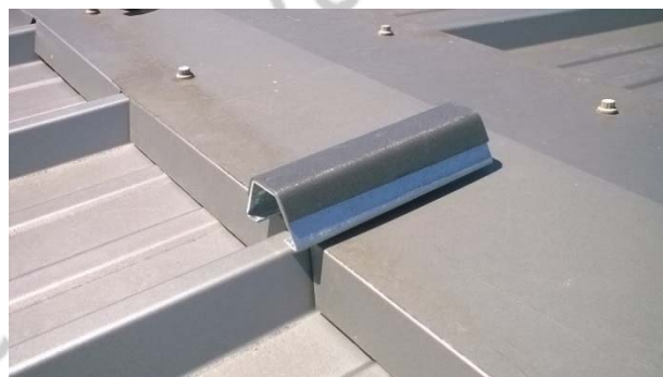
Positionnement des rehausses de faîtage : une seule par colonne de rails
