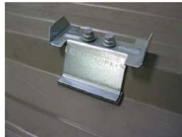
Figure 21 - Illustration de la fixation du perçage des panneaux sandwich et de la pose de l'entretoise (Cas simple vis ; pour le cas double vis voir Figure 25)
