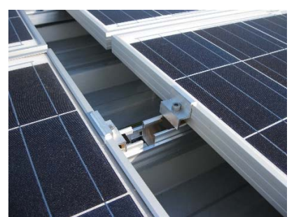
Au joint de dilatation
