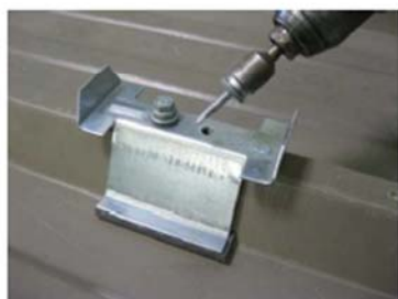
Figure 21 - Illustration de la fixation du perçage des panneaux sandwich et de la pose de l'entretoise (Cas simple vis ; pour le cas double vis voir Figure 25)
