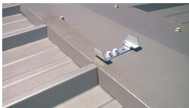
Positionnement des rehausses de faîtage : une seule par colonne de rails
