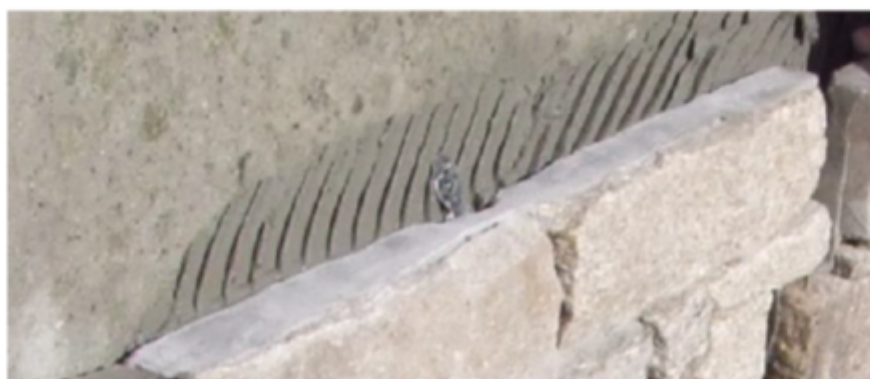
Figure 6 – STONEPANEL SKY : Mise en œuvre de l'élément de sécurité
