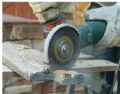
Figure 7 – Réalisation d'un angle rentrant
