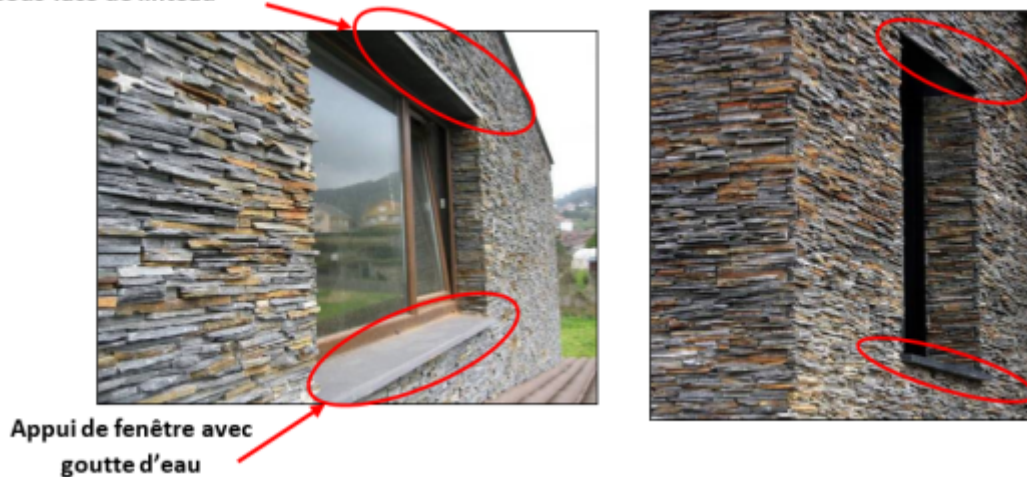
Figure 13 – Traitement de baie
