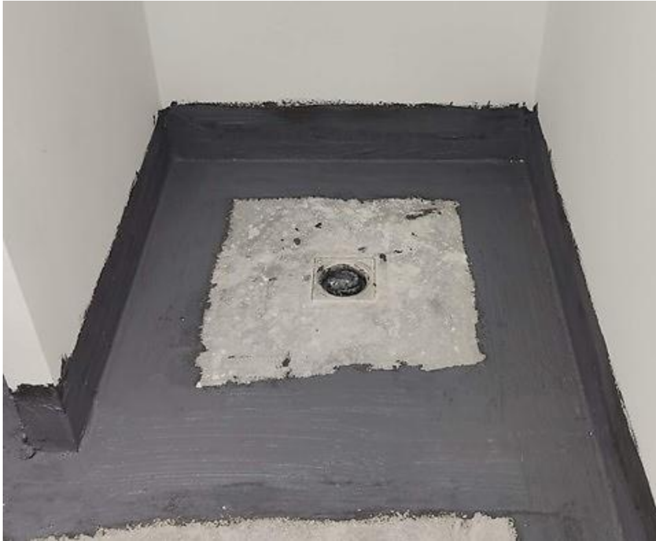
Photo 1 : Mise en place de la bande BE14 et pièces d'angle formées en périphérie du receveur PANODUR
