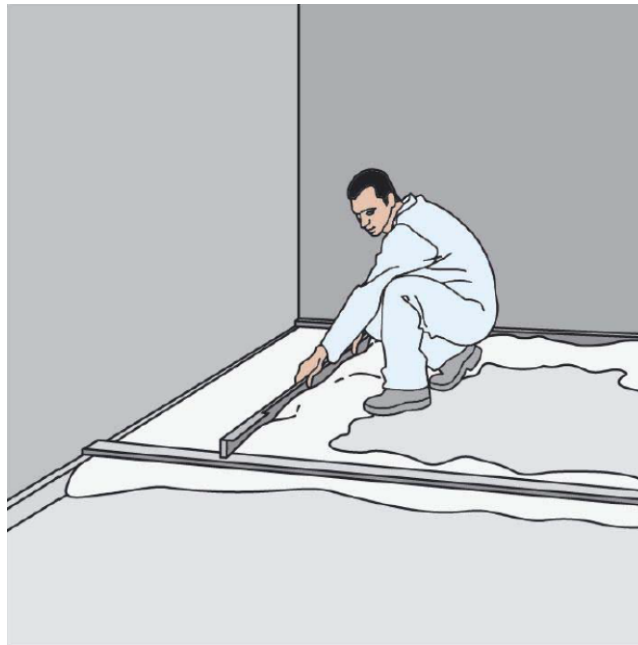
Figure 4 - mise en œuvre des granulats d'égalisation
