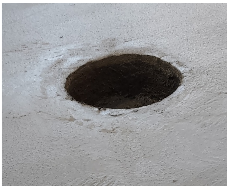
Photo 1a – Réalisation du carottage
