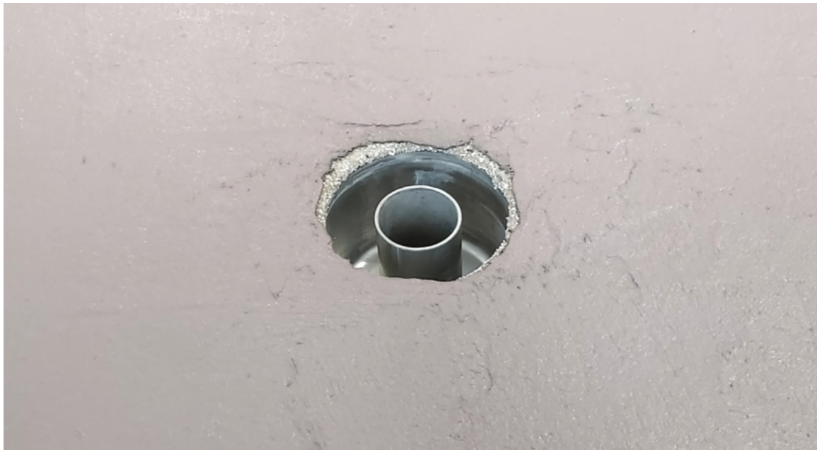
Photo 1k -Etanchéité en partie courante
