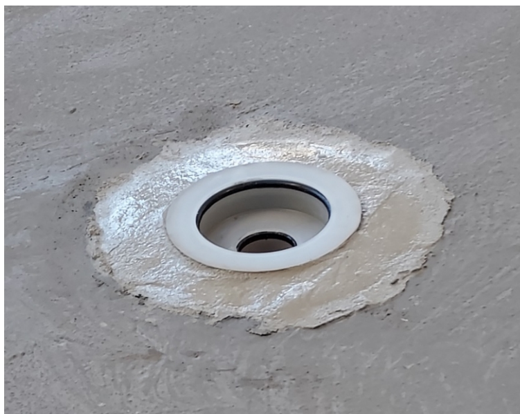
Photo 1b - Mise en œuvre de l'embase du SIPHON HYDRO PHONIQUE
