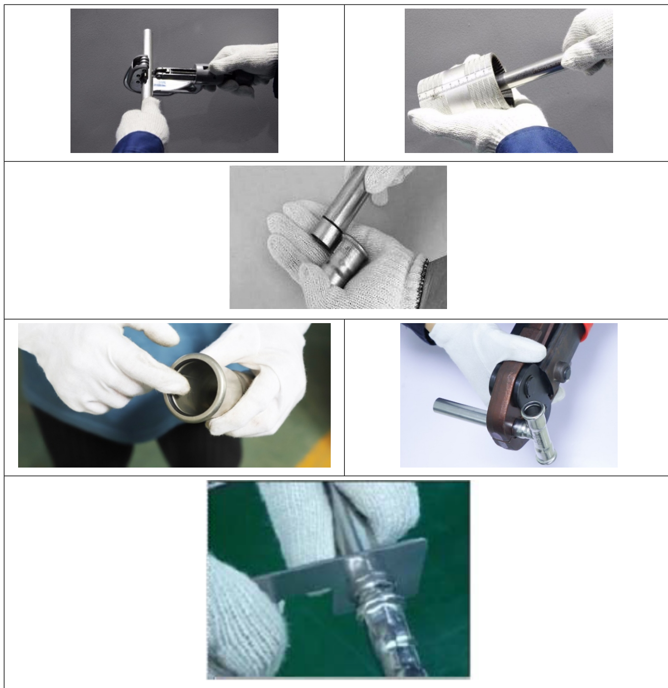
Figure 2 - Réalisation de l'assemblage
