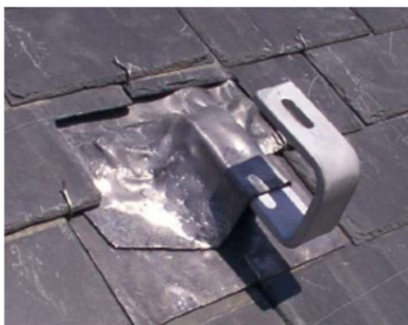
Figure 12 – Support aluminium : installation sur toitures en ardoises avec alaise en plomb
