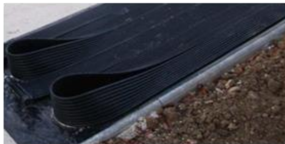
Figure 8 – Exemple de raccordement sans collecteur de bouclage
