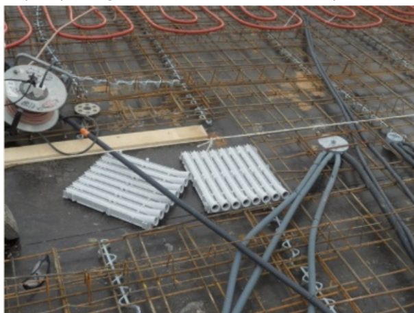
Figure 34 Pose des sorties de dalle
