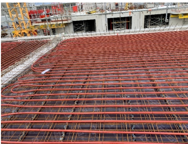
Figure 2 Détail de fixation du tube
