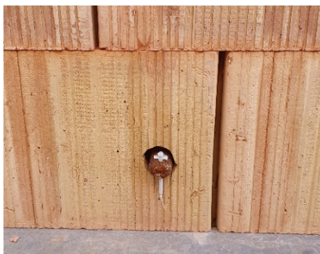
Figure 11 Broche d'ancrage en pied de mur
