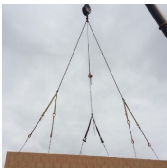
Figure 6 : Equilibrage des élingues par poules
