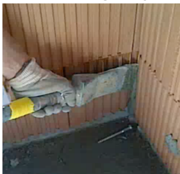
Figure 8 : « Bec » de collage des joints verticaux
