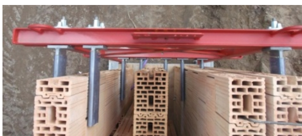
Figure 19 Détail jonction angle béton coulage chantier (ITE) (toutes zones sismiques)
