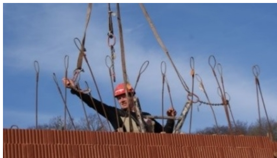
Figure 9 Boucles de levage
