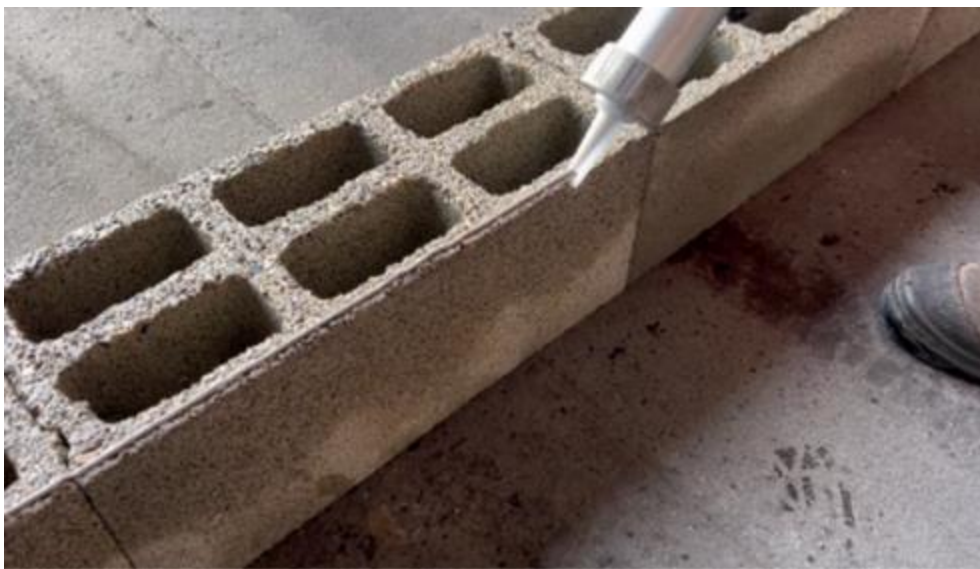
Figure 8 – Application d'un cordon de colle sur une paroi du bloc
