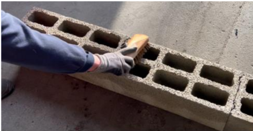
Figure 7 – Dépoussiérage des blocs
