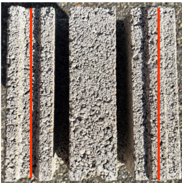
Figure 15 – Répartition des cordons de colle sur les blocs légers (granulats légers)
