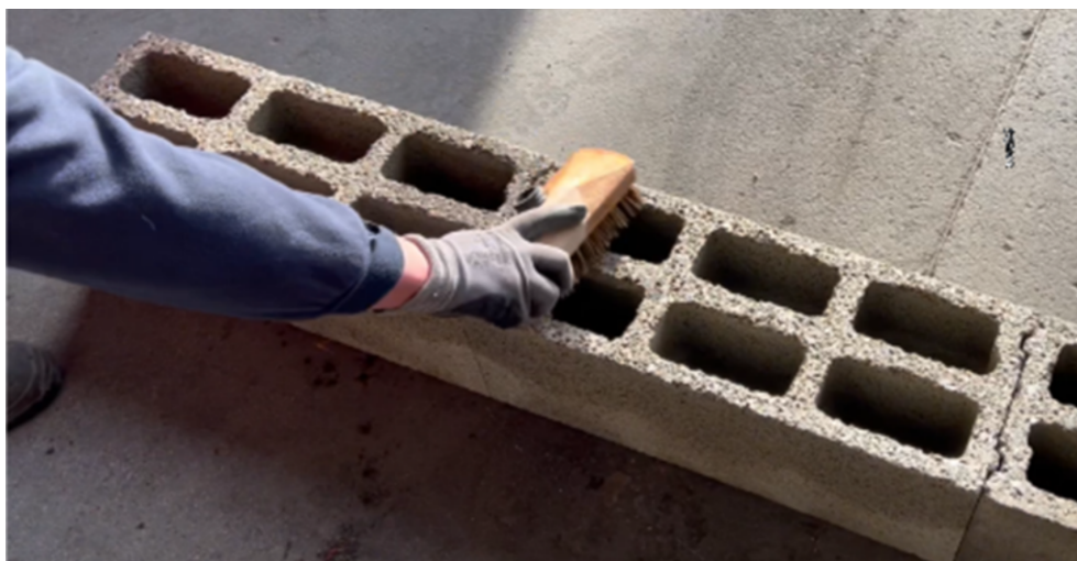
Figure 7 – Dépoussiérage des blocs
