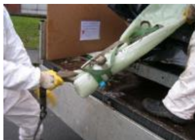
Figure 4.2 : Fixation du câble de traction
