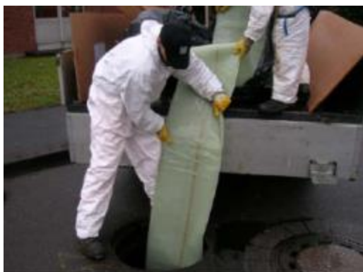
Figure 4.3 : Traction de la chemise
