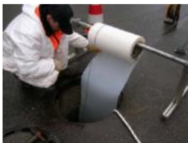
Figure 4.1 : Insertion du préliner
