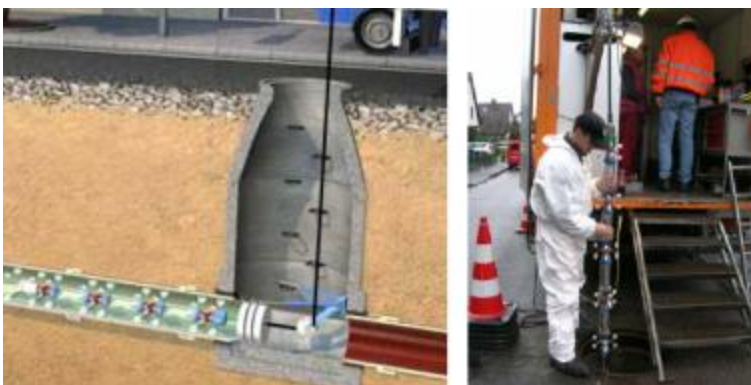
Figure 4.4 : Mise en œuvre du train de lampes
