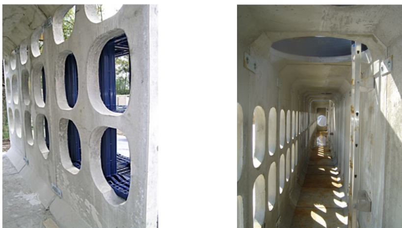
Figure 12 : Vue de la galerie d'accès en cours de mise en œuvre
