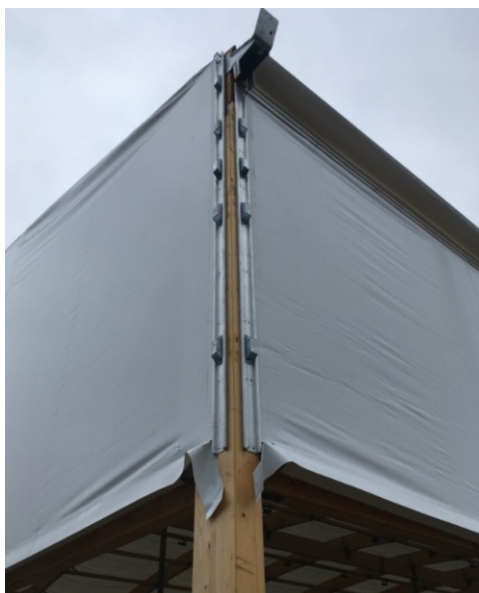
Figure 3 – Exemple de montage d'angle
