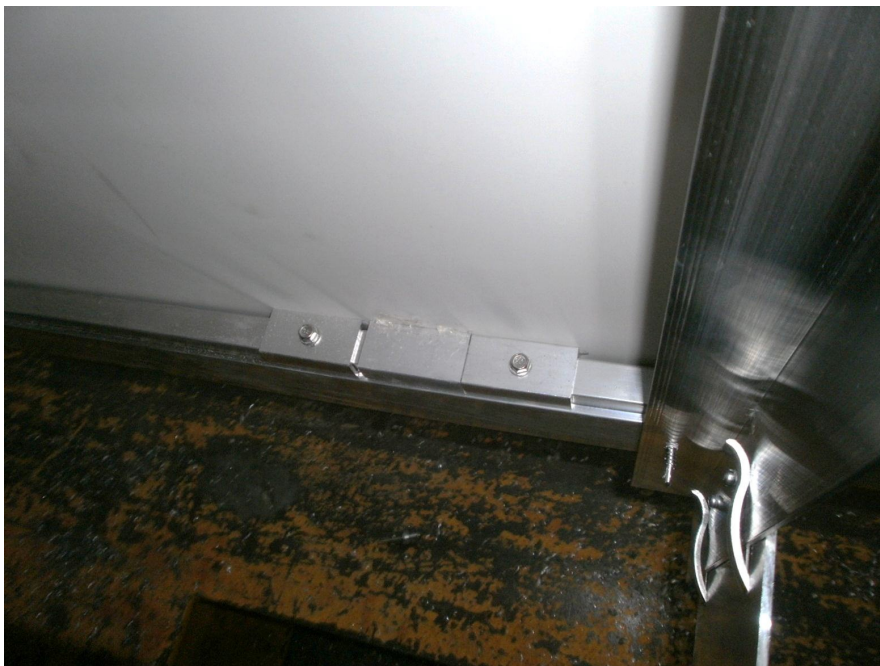
Figure A4 - Photo du principe des butées en bas des panneaux de largeur > 1500 mm (cf. § 2.13.3.6)
