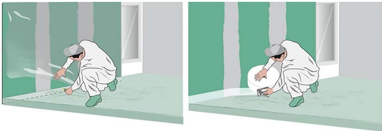
Figure 11 : Réalisation de la désolidarisation périphérique
