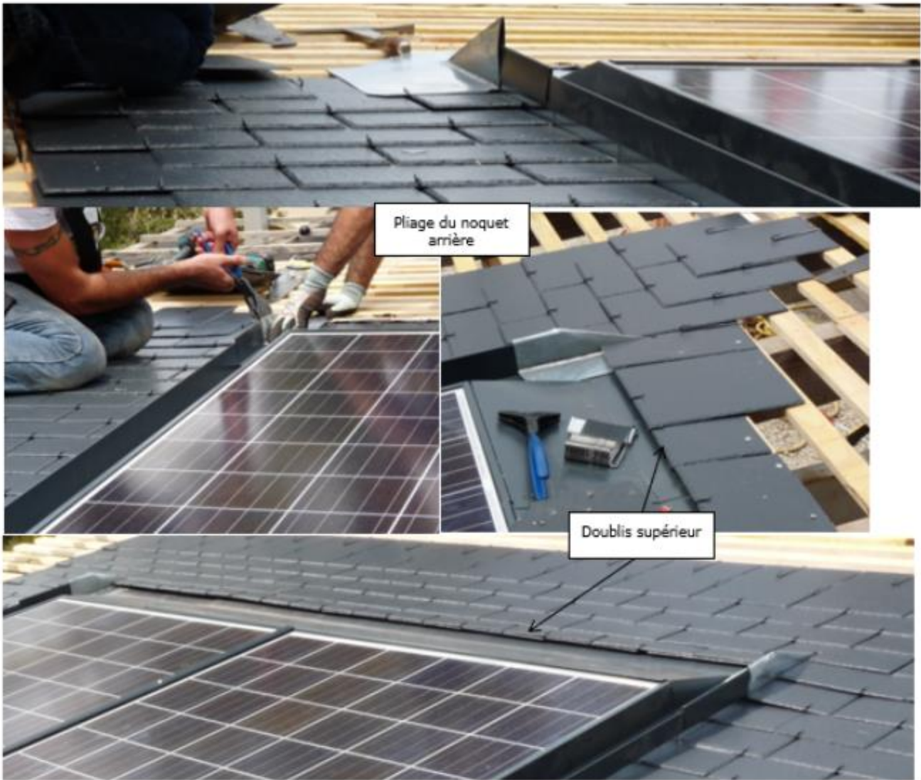
Figure 65– Recouvrement supérieur – kit PV3-1 TP/Ardoise
