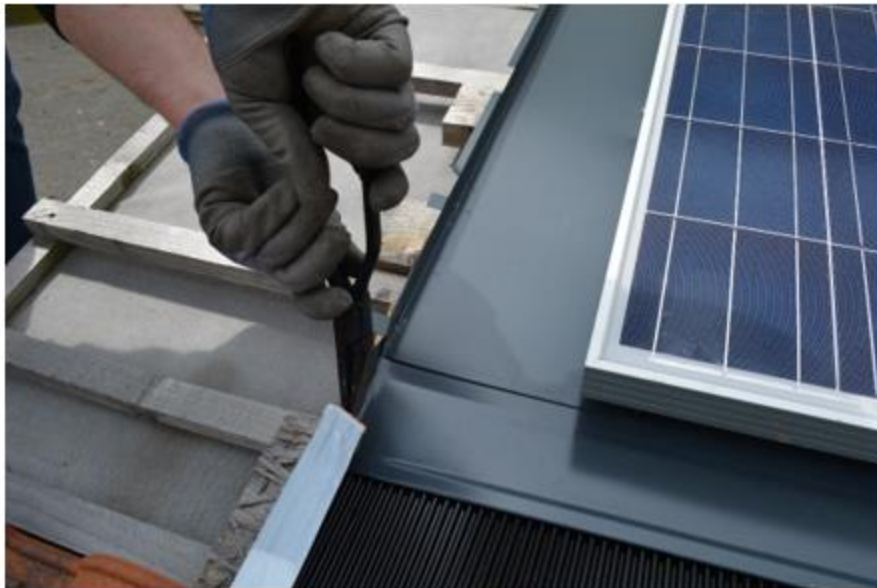
Repli de la bavette avant sur le bord du couloir latéral (kit PV3-1 S)
