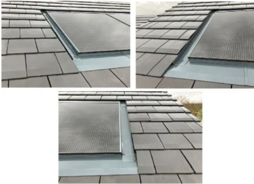
Figure 43 – Pose des bavettes rigides pureau plat Nord PV3-1 N pour tuiles à pureau plat figurant au Tableau 3
