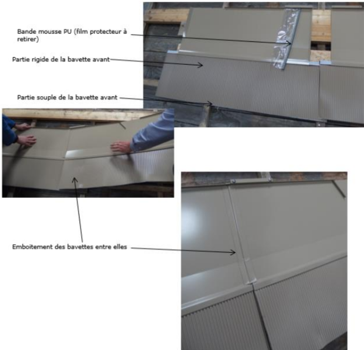
Figure 40– Pose des bavettes avant serties – kit PV3-1 S
