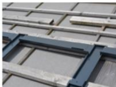
Couloir transversal / écarteur / couloir intermédiaire
