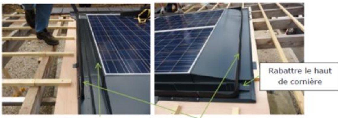
Cornière latérale fixée et mise en place de la mousse triangulaire.
