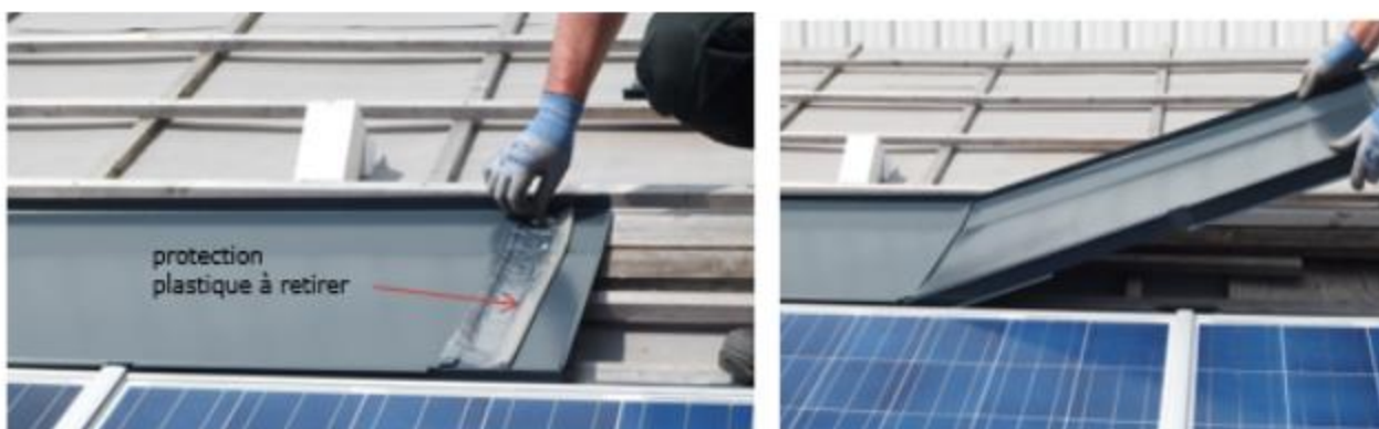
Emboîtement du capot arrière au-dessus du module et du couloir latéral
