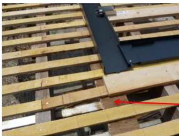
Supportage des liteaux de couverture en porte-à-faux avec planches de contreplaqué
