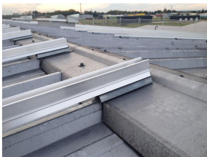
Positionnement des rehausses de faîtière : une seule par colonne de rails
