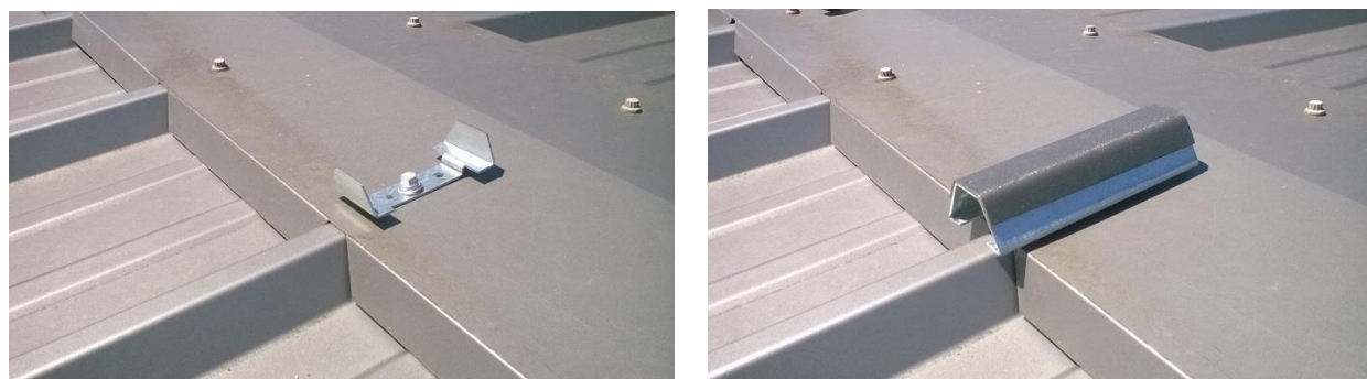
Figure 19 - Illustration de l'utilisation de la rehausse de faîtière
