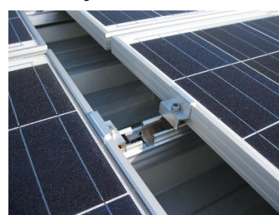
Au joint de dilatation
