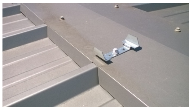
Figure 18 - Illustration de la fixation des bacs de sous-face à l'aide des rehausses inférieures avec la rehausse de blocage
