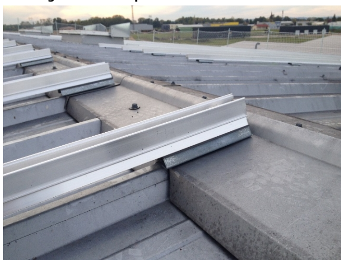
Figure 19 - Illustration de l'utilisation de la rehausse de faîtière
