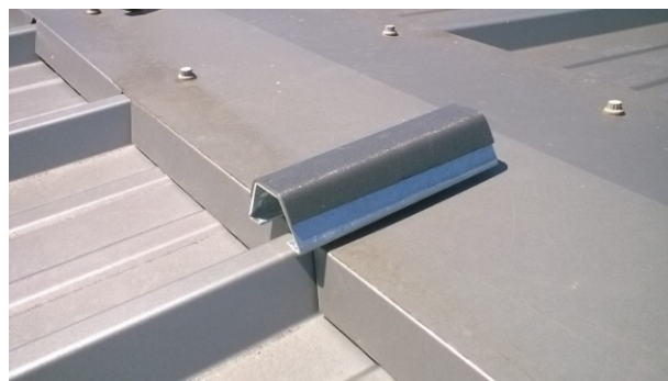
Figure 18 - Illustration de la fixation des bacs de sous-face à l'aide des rehausses inférieures avec la rehausse de blocage
