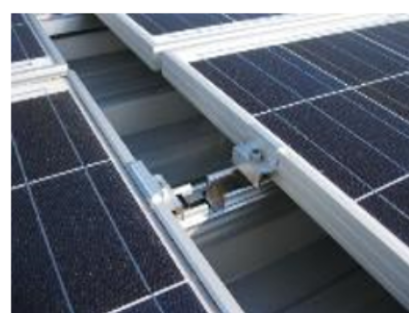
Au joint de dilatation
