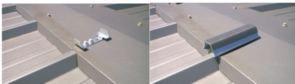
Figure 17 - Illustration de la fixation des panneaux sandwich à l'aide des rehausses inférieures avec la rehausse de blocage
