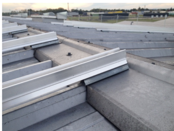
Figure 18 - Illustration de l'utilisation de la rehausse de faîtière (L'entretoise n'est pas représentée sur ces sections)
