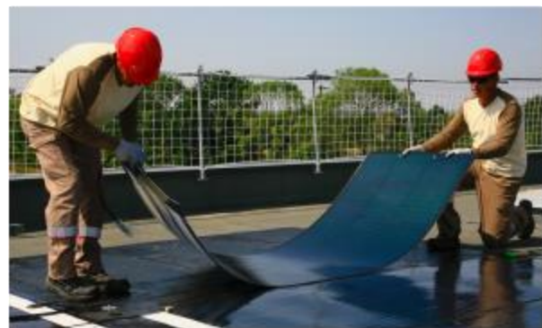
Etape 2 : pose du module sur la surface support
