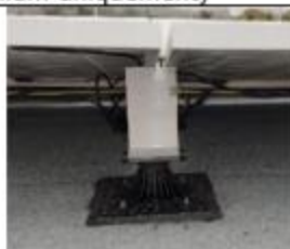
Localisation zone de perçage pour mise à la terre des rehausses Aluminium par vis autopercuse (mise à la terre de la rehausse 200 aluminium uniquement)
