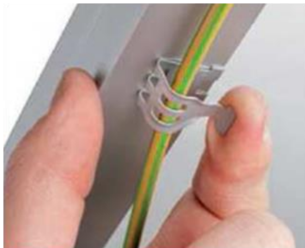
Figure 28 : clip pour fixation des câbles au cadre des modules
