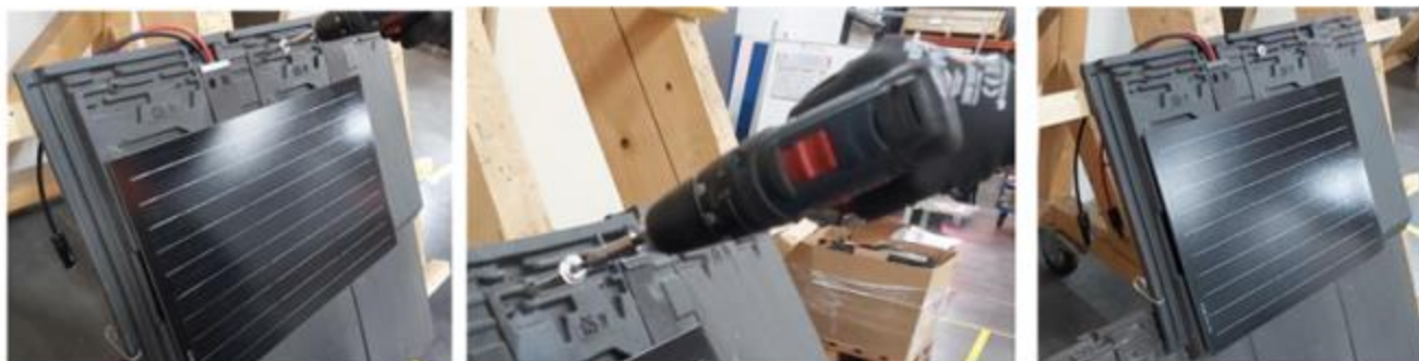
visser la Fag 10 solaire dans le trou de préperçage à l'opposé du crochet harpon (1 vis par tuile).
