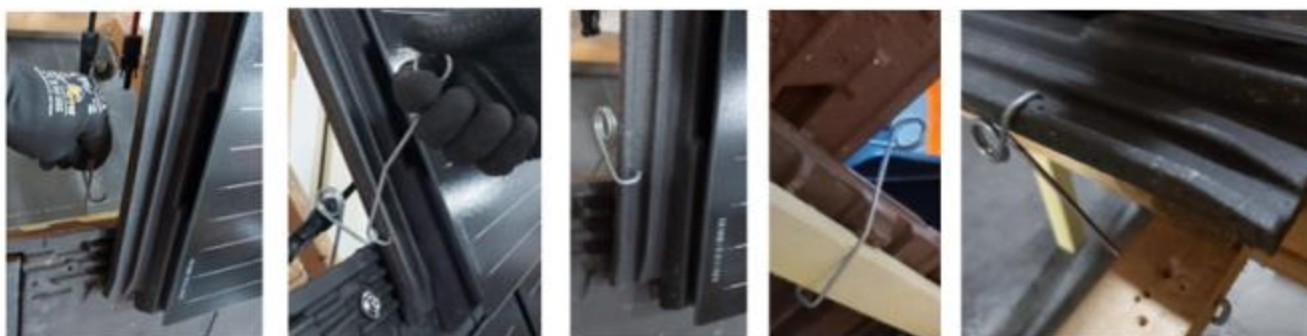
Installer le crochet Harpon dans l'emboîtement de la FAG 10 Solaire (1 crochet par produit)
