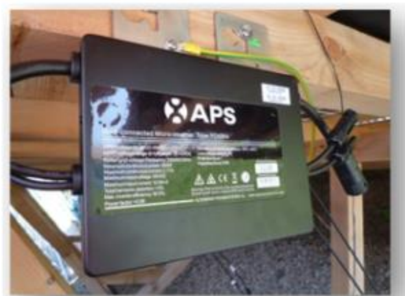
Figure 13 – Mise en œuvre d'un micro-onduleur
