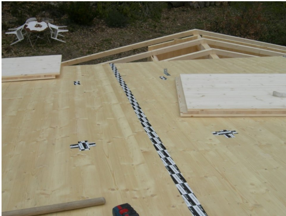
Figure 11 : Pontage des caissons et trous de levage
