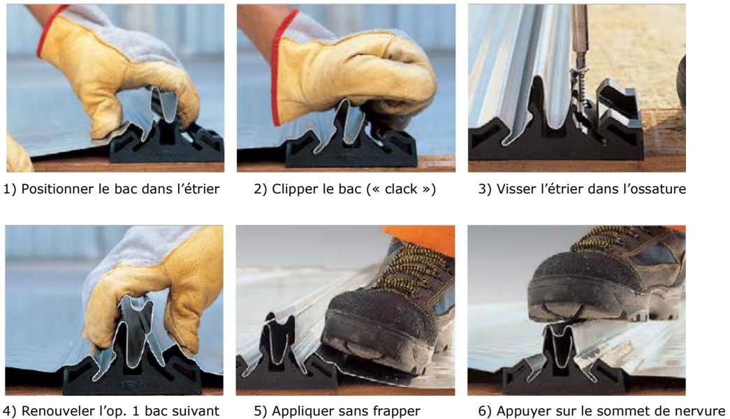
Figure 24 – Mode opératoire de pose des bacs
