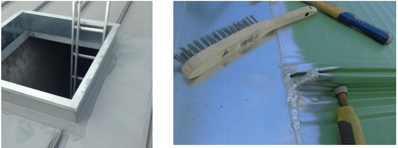
Figure 37 – Exemples de réalisation et de finition par soudure
