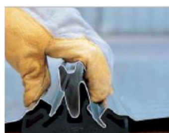
Pose de droite à gauche
