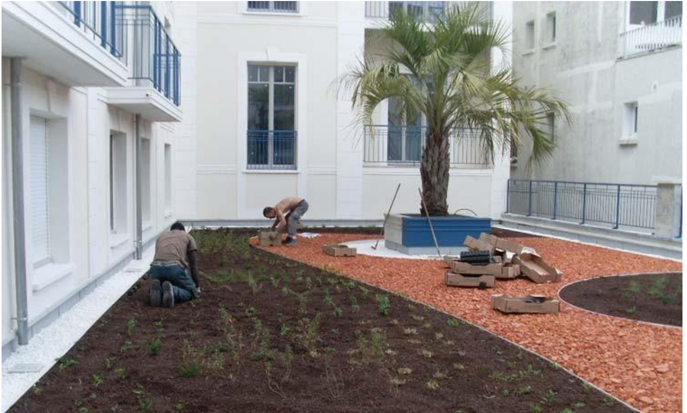
Figure 3 – Mise en œuvre du système Sopranature Tundra par plantations
