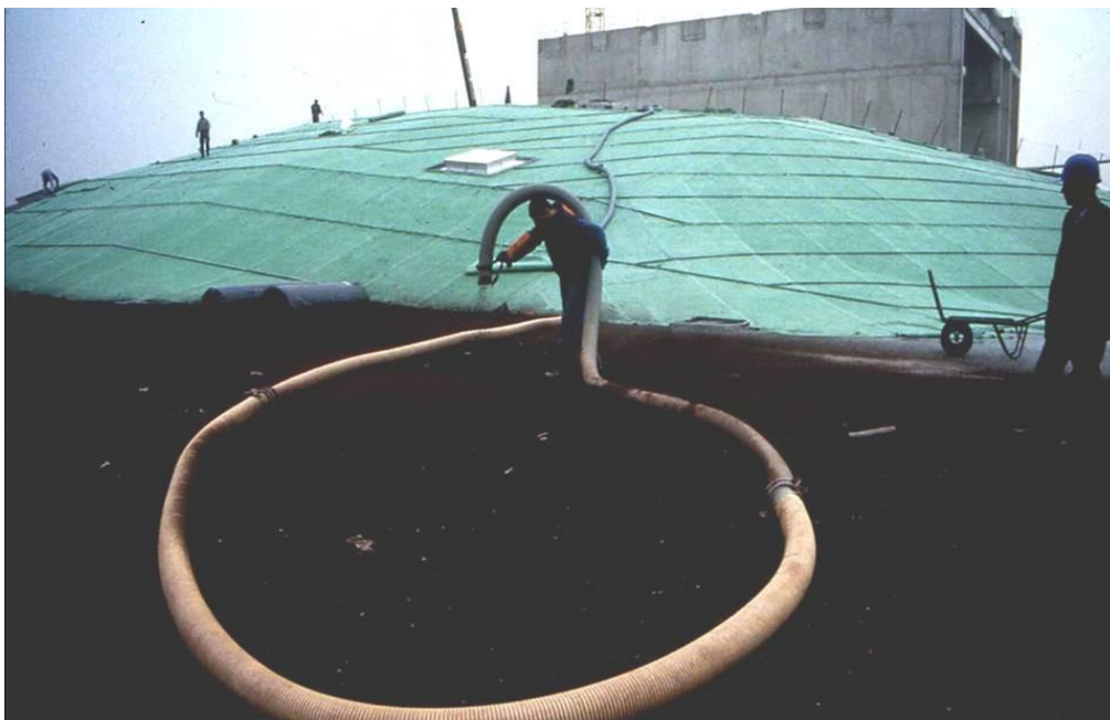
Figure 5 – Mise en œuvre du substrat (camions silos) sur le géotextile SOPRATEx 650
