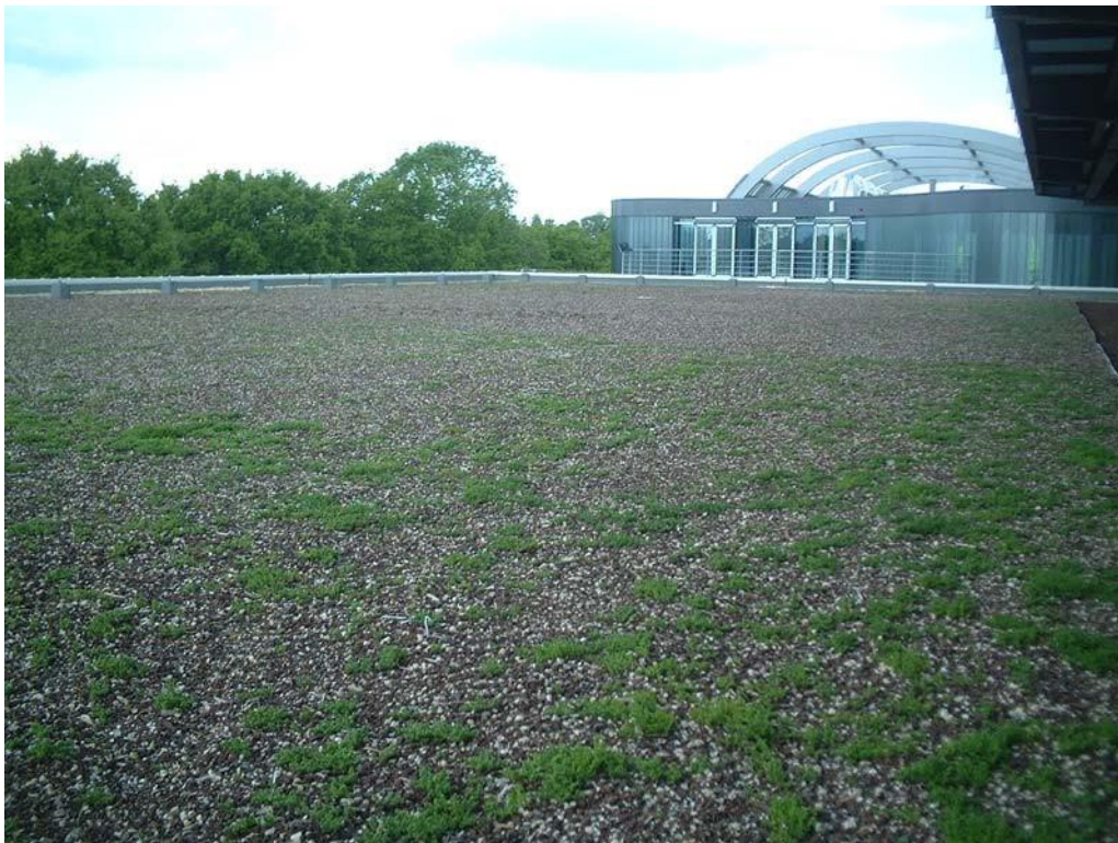
Figure 4 – Système Sopranature Tundra par semis
