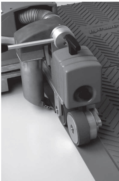
Figure 14 – Mise en œuvre des dalles de circulation Sarnafil® T Walkway Pad par thermosoudure avec un automate
