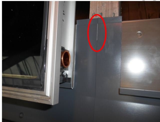
Figure 8 – Repères visuels de la tôle basse : aide au positionnement – tous kits de mise en œuvre
