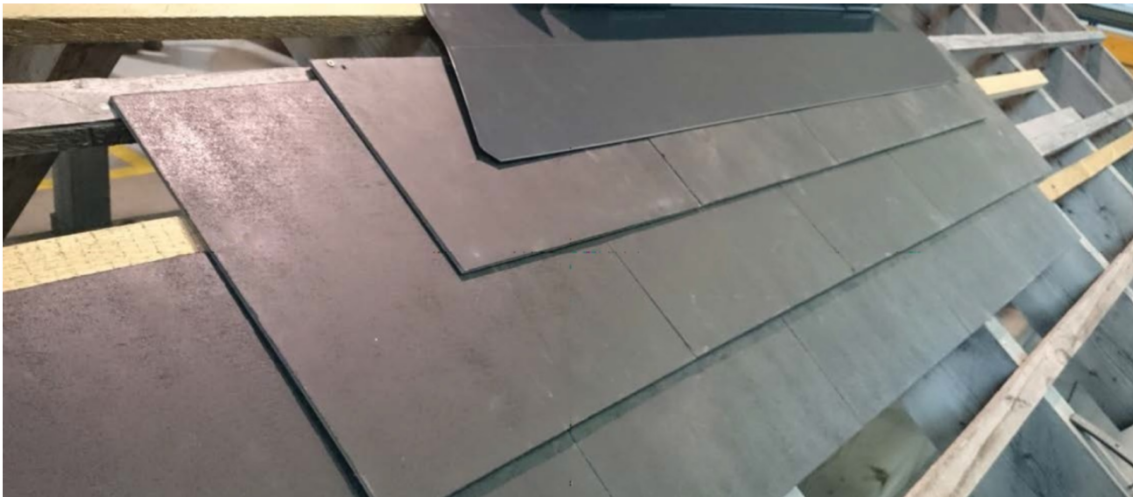
Réalisation d'un rang de doublage lors du raccordement avec des tôles
