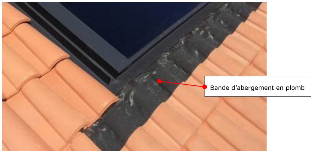
Figure 25 – Kit « COPPI TILE » - Mise en œuvre de tuiles en partie basse et latérale
