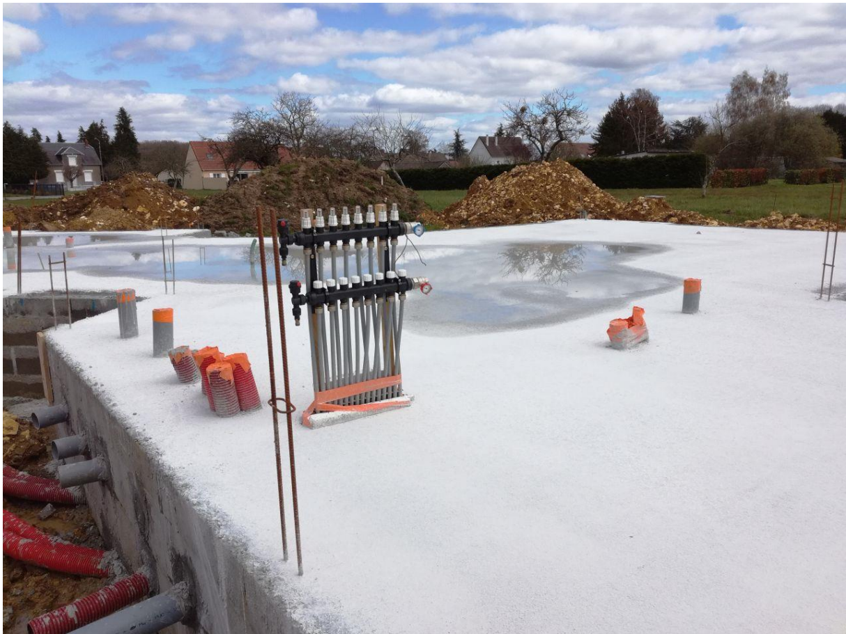
Fig. 11 : Collecteur après coulée de la dalle du vide-sanitaire
