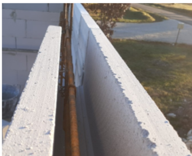
Figure 10 : Chaînage horizontal avec blocs Ytong Compact 15 TU et aciers en attente de coulage
