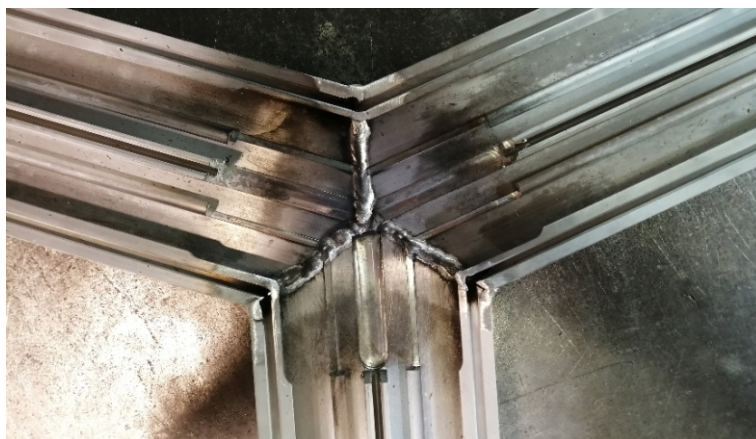
Figure 2 – Soudure d'une pièce d'angle
