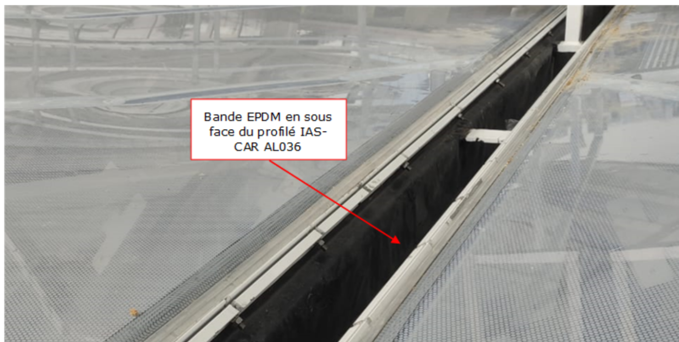
Figure 13 – Bande EPDM clipsée sous le profilé IAS-CAR AL036
