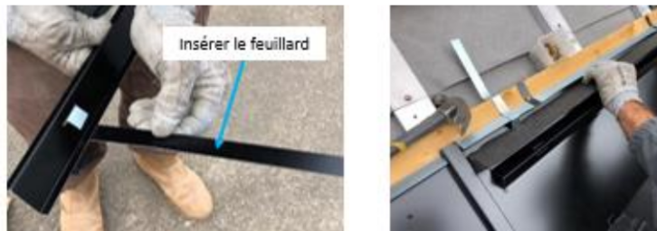
Figure 29 – Pose des appuis de tuiles (kit TS-2)
