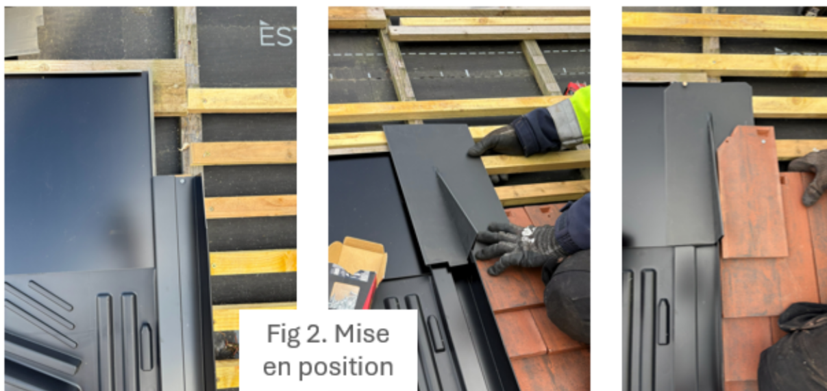
Figure 47 (suite i) – Pose des abergements latéraux et d'angles supérieurs (kit TP-1)
