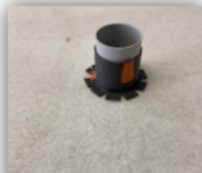
Mise en place de la sous-couche acoustique et positionnement de la bande périphérique autour du manchon provisoire
