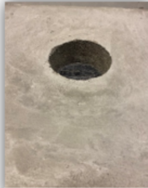
Réservation dans la dalle support
