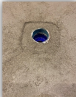
Création de l'empreinte de la platine sur la chape encore fraîche
