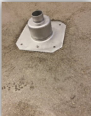
Création de l'empreinte de la platine sur la chape encore fraîche
