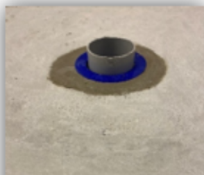
Positionnement d'une réhausse provisoire au niveau du siphon pour caler la hauteur de chape
