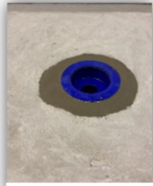
Scellement de l'embase inférieure du siphon acoustique avec Mapefill F
