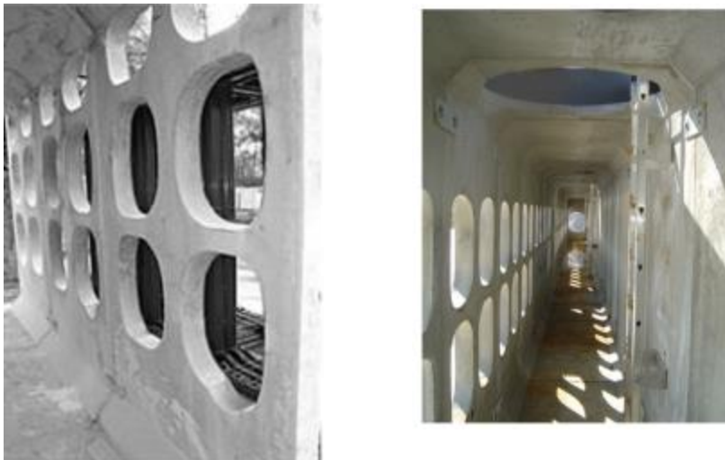
Figure 12 – Vue de la galerie d'accès en cours de mise en œuvre
