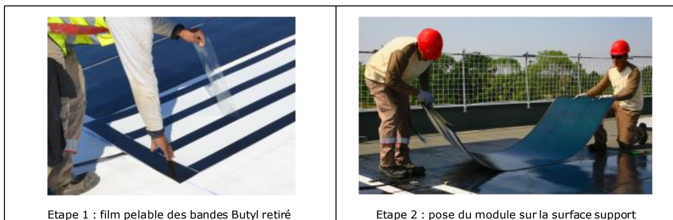
Figure 9 - Mise en œuvre du module photovoltaïque souple EXCEL®SOLAR
