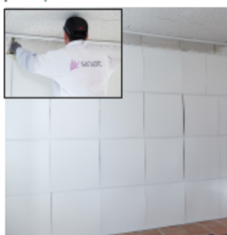
Découpe puis pose de l'isolant complémentaire dans l'espace restant. Traitement des jonctions entre les isolants avec le ruban adhésif (ne pas coller les ossatures PVC).
