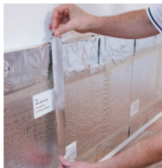
Pose des panneaux isolants SLIMISOL® et traitement des jonctions entre les isolants avec le ruban adhésif (ne pas coller les ossatures PVC).
