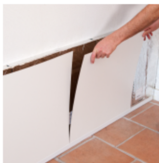
Pose des panneaux de protection SLIMISOL PAN PROTECT.
