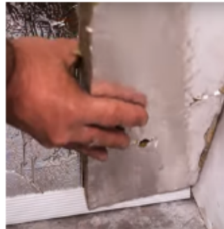
Découpe et pose de l'isolant complémentaire.
