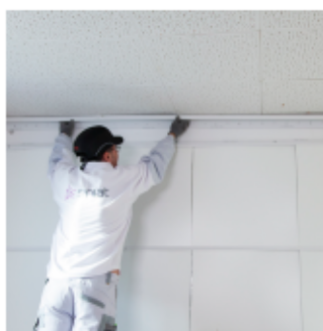
Pose du rail haut.
