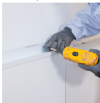
Pose de la fourrure et mise en œuvre du joint de protection.
