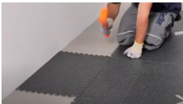
Assemblage de la dalle découpée
