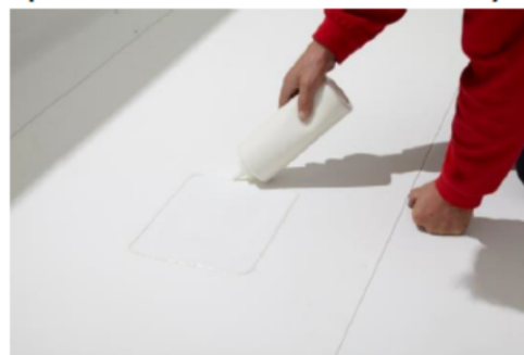
Figure 32 - Mise en œuvre du TPO Liquide Cut Edge Sealant
