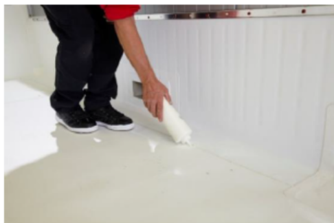
Figure 32 - Mise en œuvre du TPO Liquide Cut Edge Sealant
