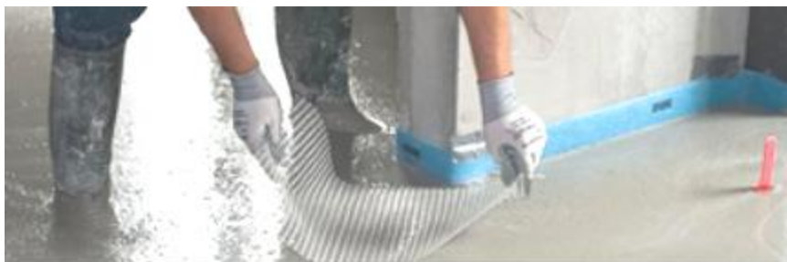
Figure 1 - Pose d'un renfort d'angle
