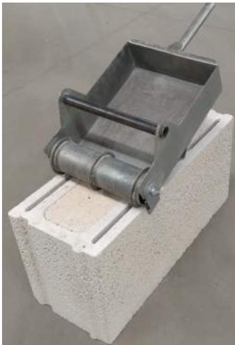
Figure 14: Application du mortier-colle des joints horizontaux sur les blocs FABTHERM AIR 1.8
