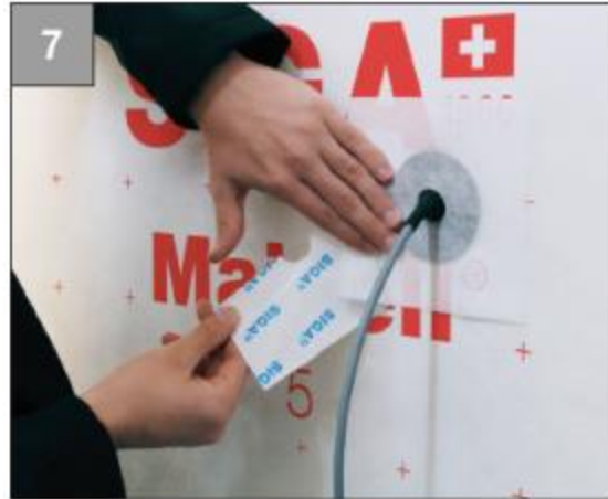
Figure 14 – Traitement du passage d'une gaine électrique avec la Manchette SIGA Fentrim
