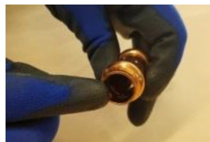
Vérifier la présence du joint
