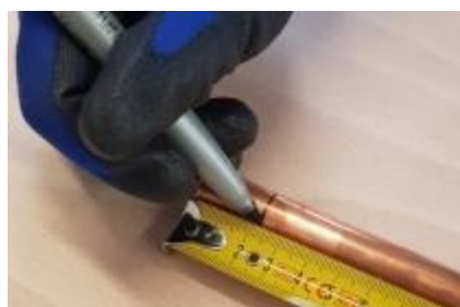
Marquer la profondeur d'emboiture
