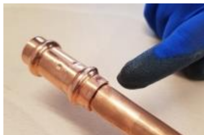
Vérifier la position et le bon sertissage
