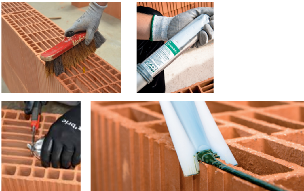
Figure 10 : Préparation pour la pose du procédé POWERBRIC
