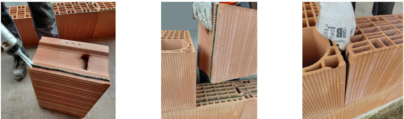
Figure 14 : Pose d'un cordon esthétique POWERBRIC sur la boutisse de la brique posée sur la face retour du poteau dans les angles de murs
